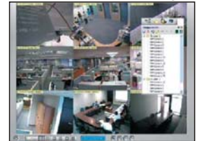
GV-Control Center: Zentrale Vernetzung
